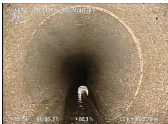
Figure 16 : Conduite PEHD Ø32 mm dans le radier du réseau d'assainissement
