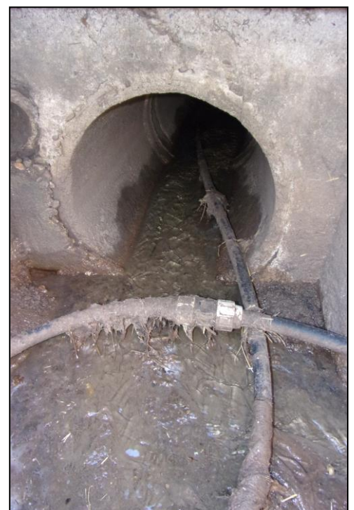
Figure 4 : Conduite PEHD Ø32 mm posée dans le réseau d'assainissement
