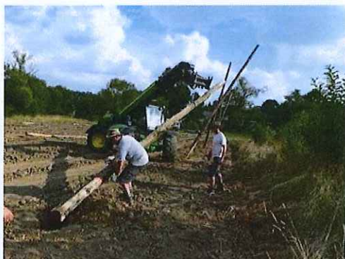
Très spectaculaire l'élévation des 15 pieux d'acacia de 8 mètres de haut.
